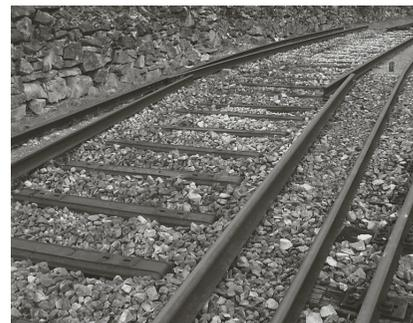
Die Schienen zum Austausch liegen bereit, die Stahlschwellen sind schon verlegt. Nun kann keine Schwelle mehr faulen – nur noch rosten.
