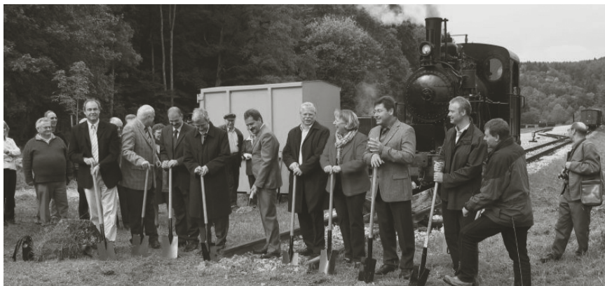
Ersten Spatenstich 25. September 2007: gleich werden die Honoratioren aktiv
