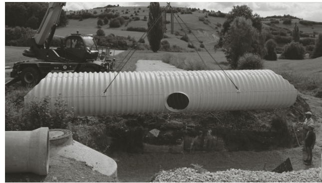
9. August 2020: der Wellrohrdurchlass wird eingekrant
