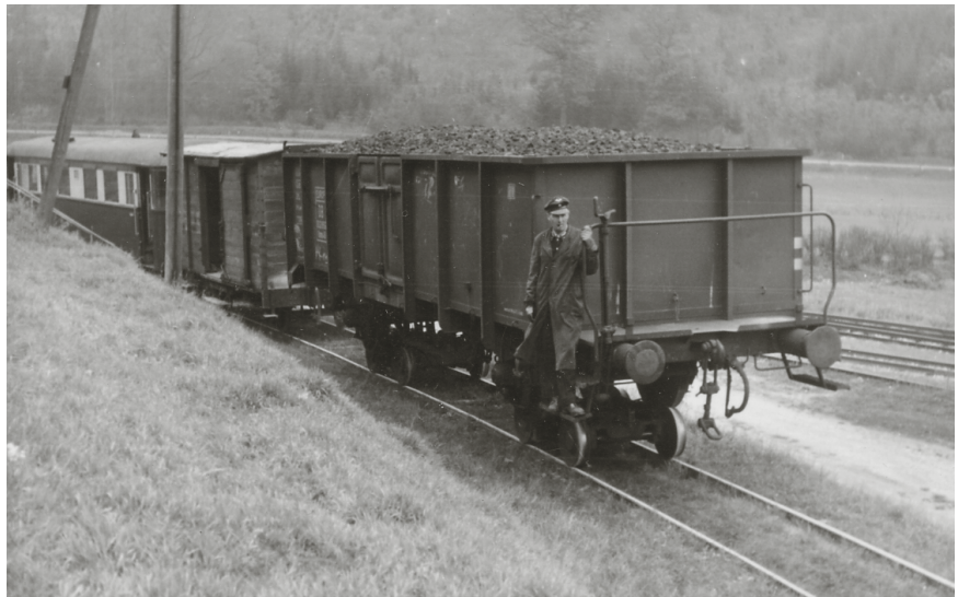
Der T 32, gekuppelt über den Gw 118, schiebt den mit Koks beladenen Wagen die steile Rampe hinauf.
