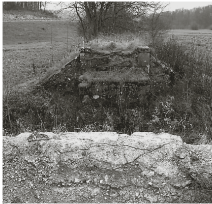
Vom ruinierten Ausgangszustand ... Foto: Gerald Stempel
