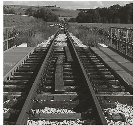
... bis zur fertigen neuen Brücke Foto: Gerald Stempel
