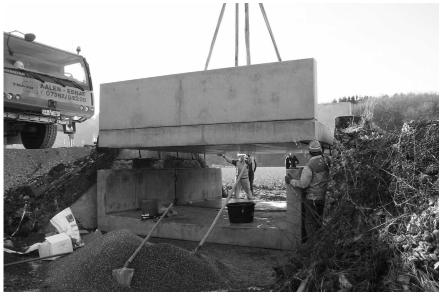
Unten: Am 12. November 2015 wurde der Flutdurchlass als letztes großes Hindernis auf dem Weg zum Härtsfeldsee eingebaut. Foto: Werner Kuhn
