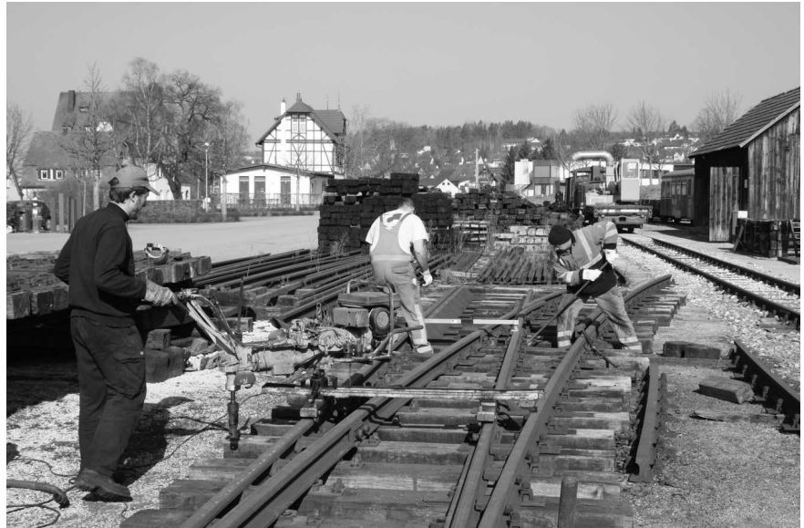
Oben: Die erste Weiche für den zukünftigen Endbahnhof Katzenstein am Härtsfeldsee wurde im März 2015 aufgearbeitet.
