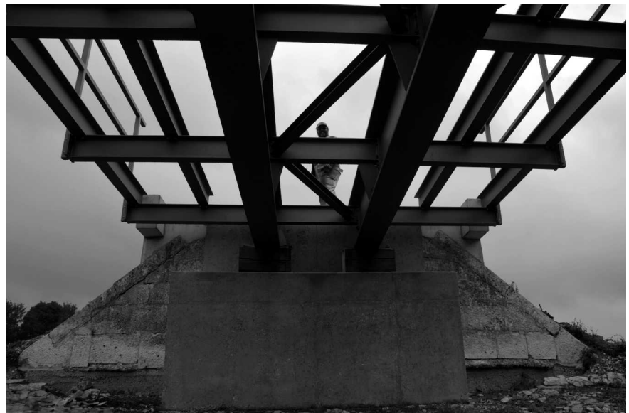
So sah die neue Egau-Brücke am 1. September 2012 aus Sicht einer Ente aus. Noch führen keine Gleise darüber. Foto: Jürgen Ranger
