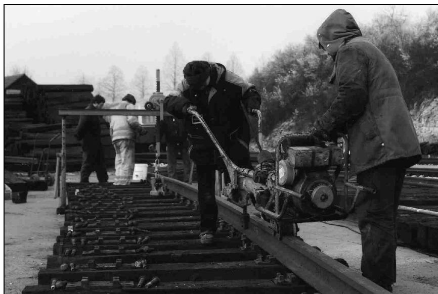
Unten: Gleisbaustelle Neresheim: Hier werden die Joche vormontiert und dann komplett an Ort und Stelle transportiert. Foto: Hannes Ortlieb
